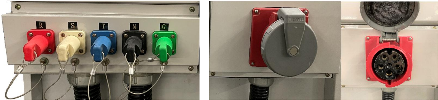
圖例 3.6- 外接電源 Camlock、CEE125 圖示
